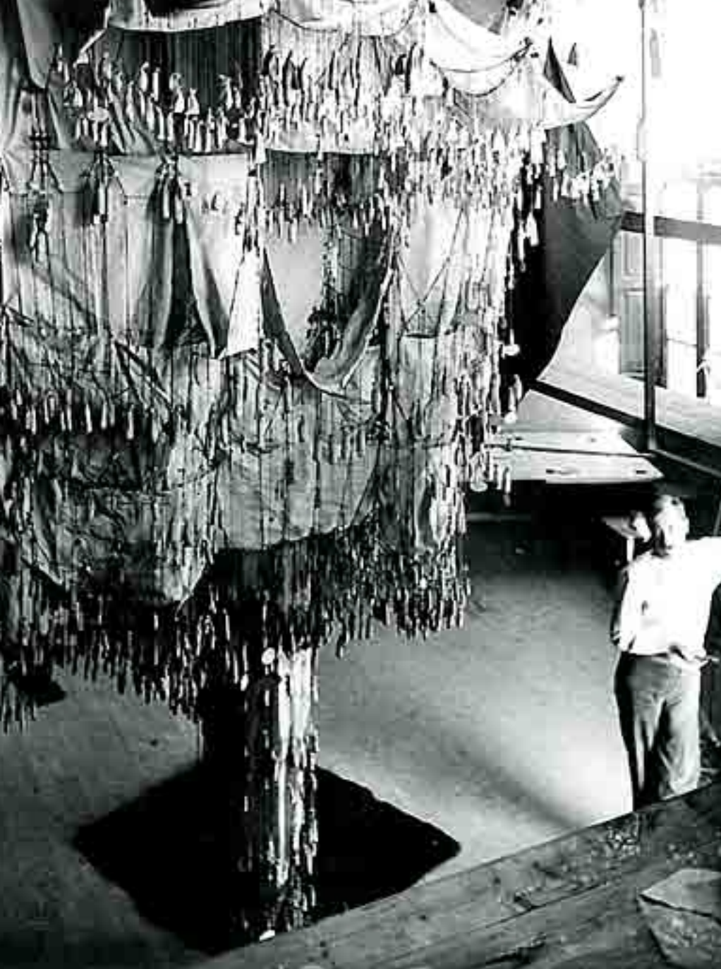
Modelo de pesos invertidos para A Sagrada Família de Gaudi
